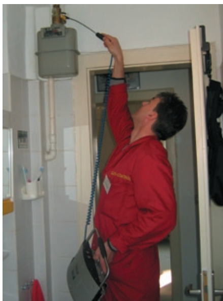
Zerstörungsfrei werden Gasleitungen geprüft
