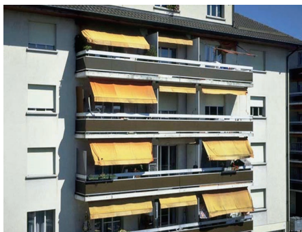
Gebäudeanalyse mit epiqr: Fassade Zustand A, kein Eingreifen nötig.
