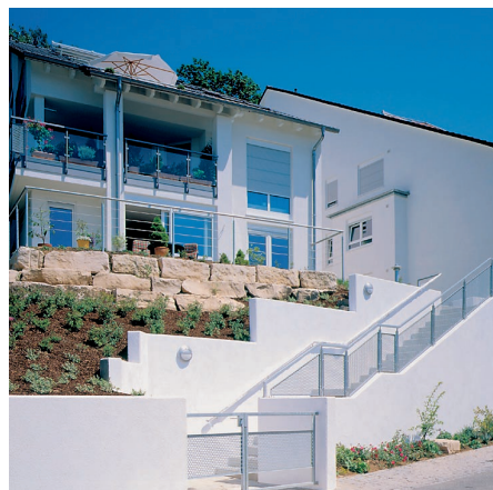
Obere Burghalde, Leonberg: schlüsselfertiger Neubau einer Wohnanlage mit Tiefgarage
