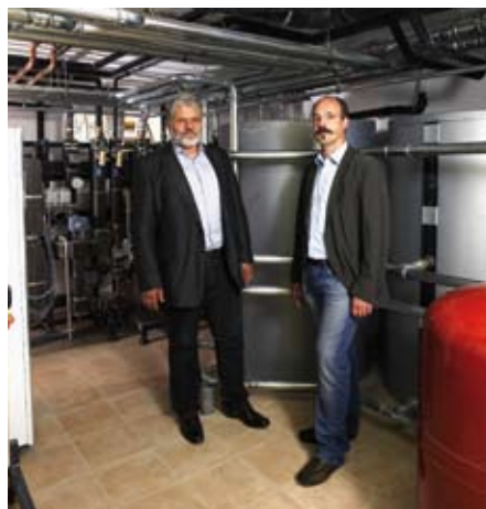
Das LSS-TC (links) verbindet Solarthermie, Erdwärme und effiziente Gas-Brennwerttechnik. Links Claus Solbach, Geschäftsführer der Sozialen Hilfe Marburg e.V., rechts der Planer Javier Perugorria von Haustechnik Perugorria. (Quelle: Junkers)
