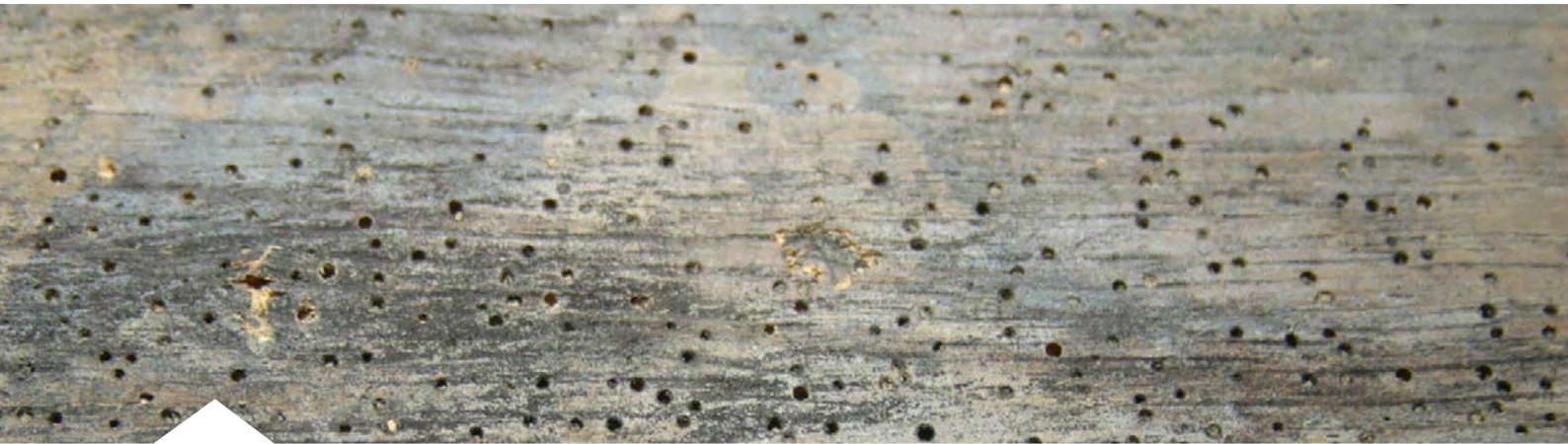
Abb. 3: Zahlreiche 2 mm große Fluglöcher im Splint eines Eichenbalkens
