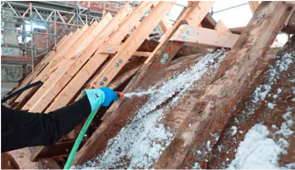
Abb. 9: Holzschutzmittelbehandlung mit einem borsalzhaltigen Wirkstoff im Schaumverfahren
