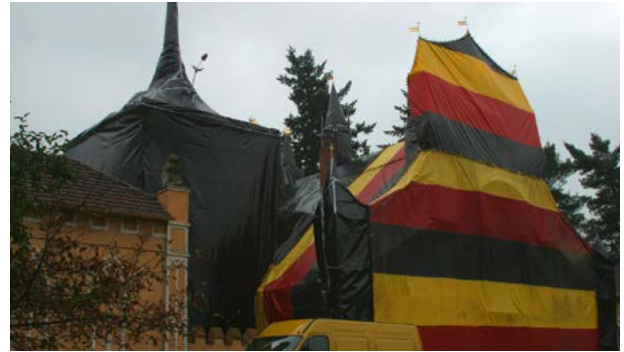
Abb. 11: Begasung zur Bekämpfung holzerstörender Trockenholzinsekten
