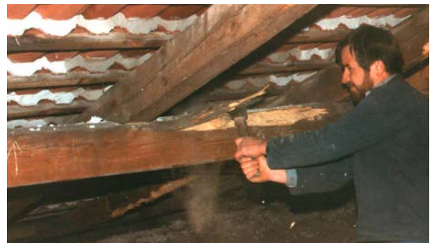
Abb. 12: Bebeilung an den Kanten der Dachverbandshölzer
