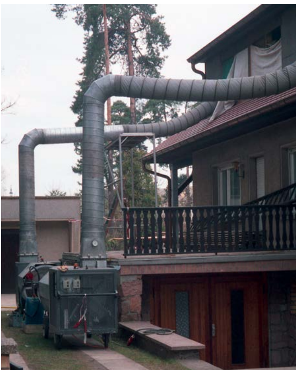
Abb. 10: Heißluftbehandlung in einem Dachstuhl zur Hausbockbekämpfung
